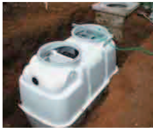
合併浄化槽の設置状況(浄化槽市町村整備推進事業)
